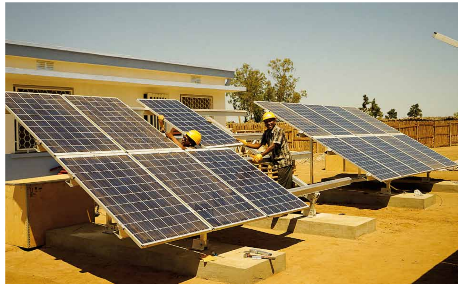
INSTALLATION DES PANNEAUX SOLAIRES À MADAGASCAR © DR
